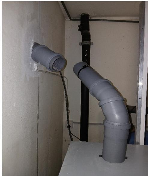
Arrivage du pellet dans le réservoir de la chaudière avec système de déboisement simple permettant l'ouverture du réservoir de la chaudière pour un remplissage manuel.
