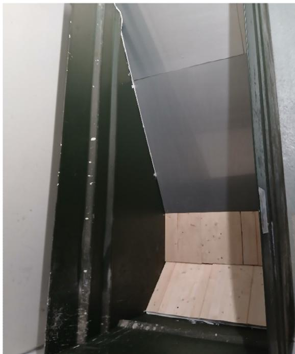
Récupération du bac de rétention et façonnage d'un fond cône (à 35°).
