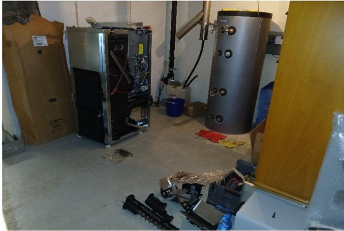
Mise en place de la chaudière à pellet, d'un ballon tampon de 300 lt, d'un vase d'expansion de 25 lt et d'une nouvelle pompe de recirculation.
