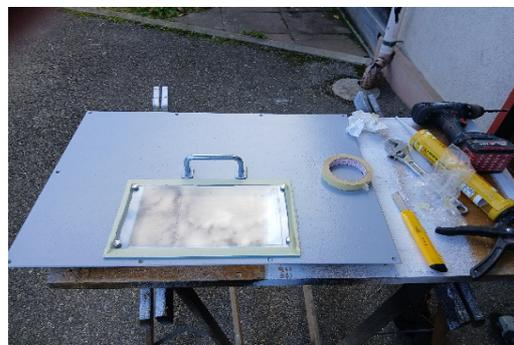
Rehaussement du bac en acier zincor 1.5 mm étanche avec renforts, porte de visite, fenêtre pour vision du niveau du pellet, ouvertures pour prises Storz (Remplissage et raccord d'aspiration) et passage pour la vis sans fin.
