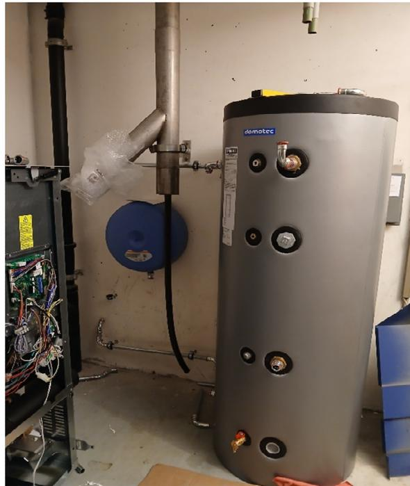
Installation hydraulique avec vanne à bille pour eau chaude. Isolation des conduites. Robinet de vidange et de remplissage. Thermomètre pour la température de l'eau chaude dans le ballon. Résistance électrique pour le chauffage du ballon tampon en cas de pénurie de pellet ou de panne de la chaudière.
